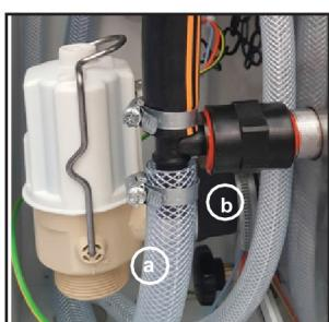
3. 取下门，拆掉夹子。彻底拆下蒸汽软管（图 2），并将其从设备上移除。
