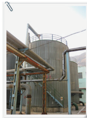
图幅II管带凝结水集中 回收到一热力车间除盐水罐中。
