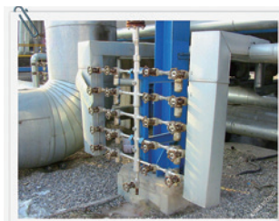
用凝结水管束对管网输水进行余压回收。
