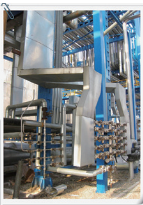
用凝结水管束对管网输水进行余压回收。
