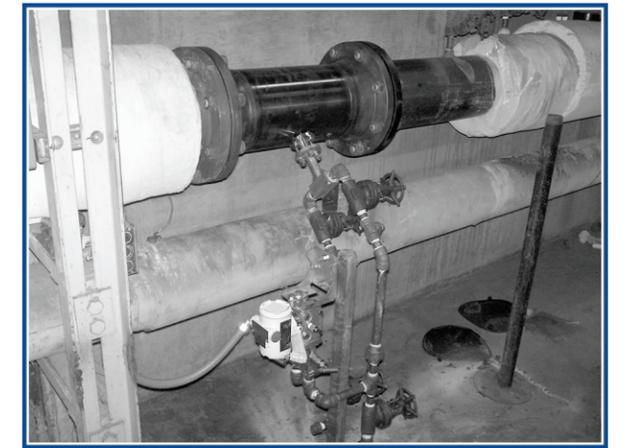
蒸汽管线中的艾伯特流量计
