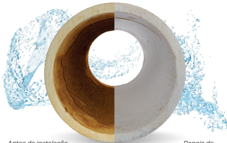
Antes da instalação do gerador de nanobolhas
